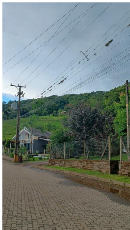
Figura 28- Evidência de Campo Serra, Município de Nova Petrópolis - Fonte: CPFL RGE
