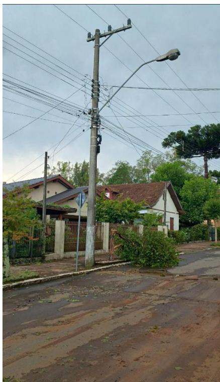
Figura 27- Evidência de Campo Serra, Município de Nova Petrópolis - Fonte: CPFL RGE
