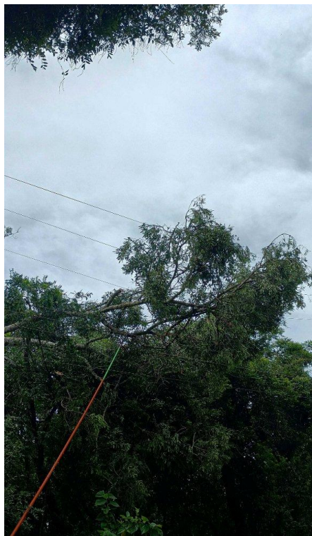
Figura 55- Evidência de Gravataí, Canoas - Fonte: CPFL RGE
