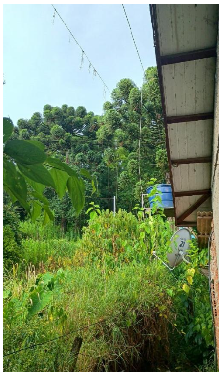
Figura 29- Evidência de Campo Serra, Município de Nova Petrópolis - Fonte: CPFL RGE
