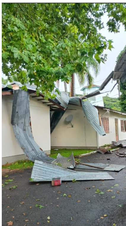
Figura 26- Evidência de Campo Serra, Município de Nova Petropolis - Fonte: CPFL RGE
