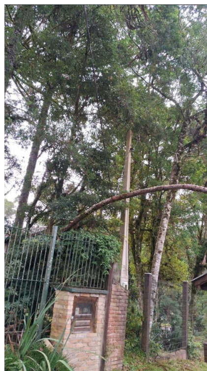
Figura 20- Evidência de Campo Serra, Município de Canela- Fonte: CPFL RGE
