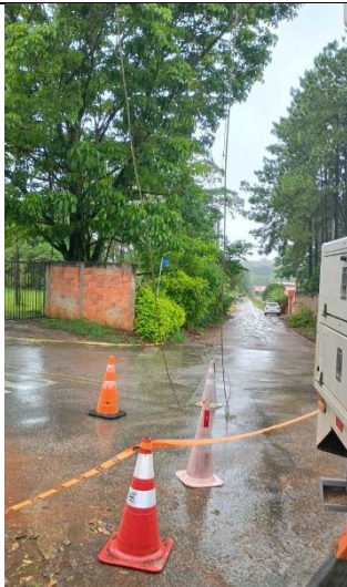
Figura 62 - Evidência de Campo - Sul, Araçoiaba da Serra/SP –Fonte: CPFL Piratininga
