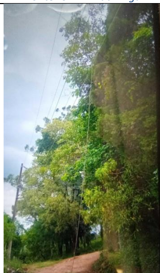
Figura 35 - Evidência de Campo - Sul, Mairinque/SP –Fonte: CPFL Piratininga
