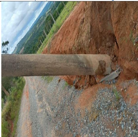
Figura 52 - Evidência de Campo - Sul, Salto de Pirapora/SP –Fonte: CPFL Piratininga
