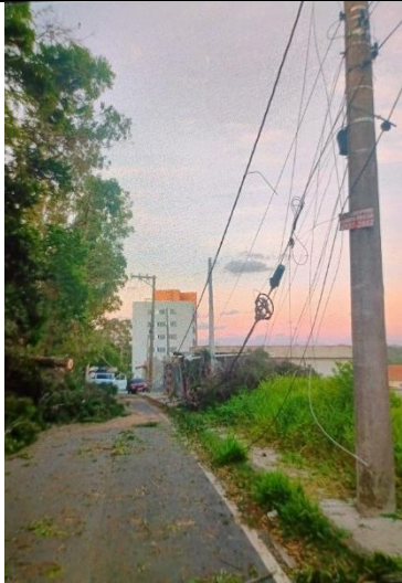
Figura 38 - Evidência de Campo - Sul, São Roque/SP – Fonte: CPFL Piratininga
