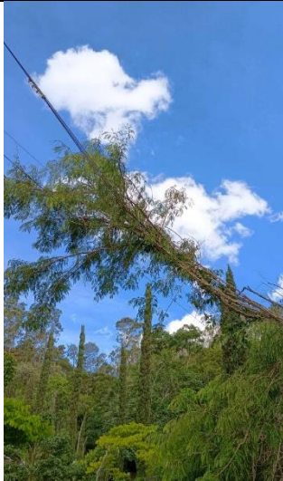
Figura 42 - Evidência de Campo - Sul, Araçariguama/SP –Fonte: CPFL Piratininga
