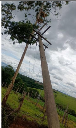
Figura 50 - Evidência de Campo - Sul, Salto de Pirapora/SP –Fonte: CPFL Piratininga
