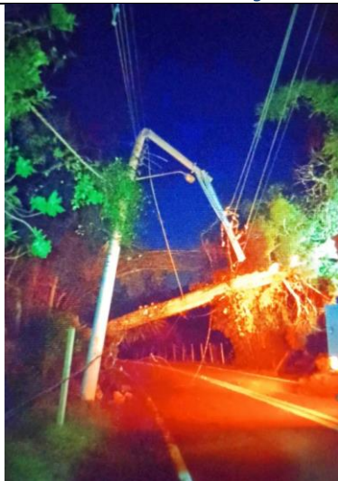
Figura 28 - Evidência de Campo - Sul, São Roque/SP – Fonte: CPFL Piratininga
