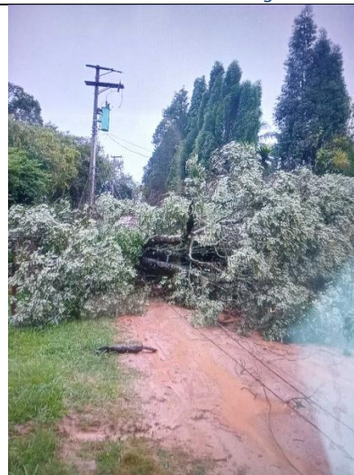
Figura 53 - Evidência de Campo - Sul, Mairinque/SP –Fonte: CPFL Piratininga
