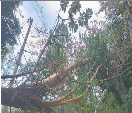
Figura 26 - Evidência de Campo – Sudeste, Jundiaí/SP – Fonte: CPFL Piratininga
