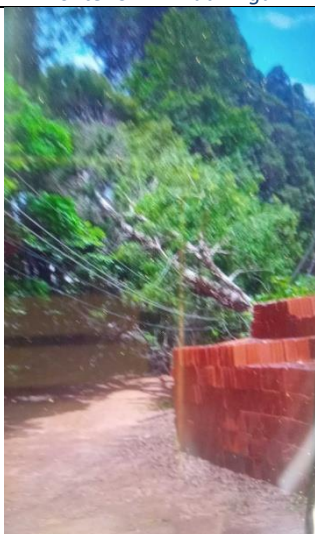
Figura 34 - Evidência de Campo - Sul, Mairinque/SP – Fonte: CPFL Piratininga
