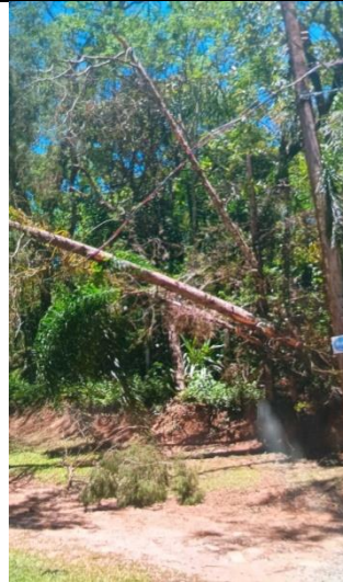
Figura 25 - Evidência de Campo – Sul, São Roque/SP –Fonte: CPFL Piratininga
