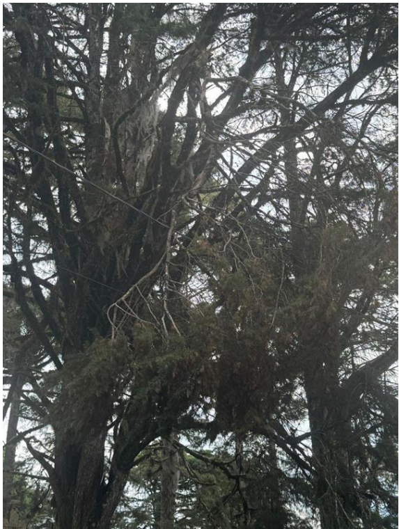
Figura 22 - Evidência de Campo Vale do Rio Pardo, Município Canela - Fonte: CPFL RGE
