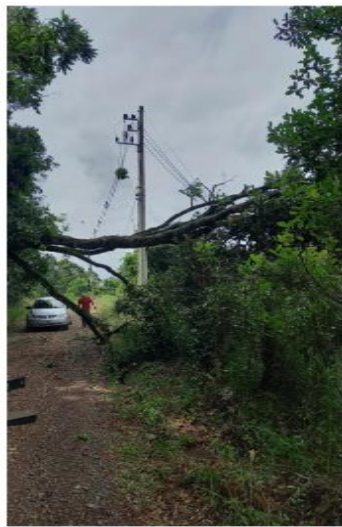
Figura 21 - Registro Fotográfico – Fonte: CPFL RGE
