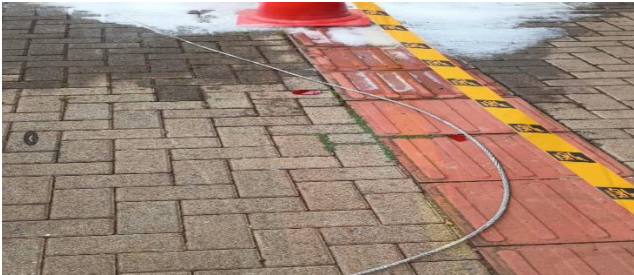
Figura 25 - Registro Fotográfico – Fonte: CPFL RGE
