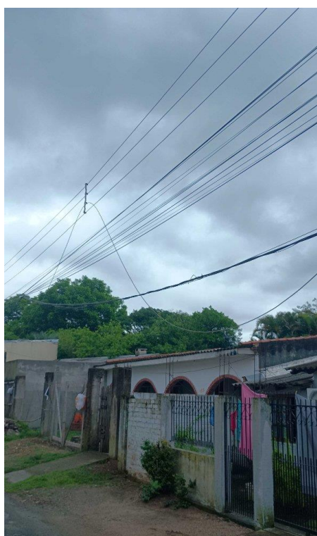
Figura 29 - Evidência de Campo Canoas, Município de Canoas - Fonte: CPFL RGE
