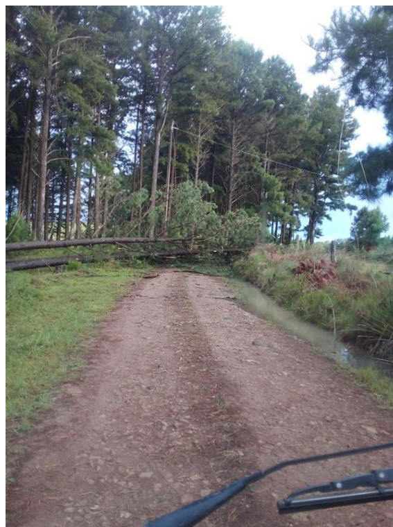
Figura 24 - Evidência de Campo Serra, Município de Cambara do Sul - Fonte: CPFL RGE
