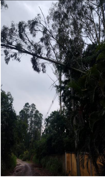
Figura 21 - Evidência de Campo - Sul, Boituva/SP – Fonte: CPFL Piratininga
