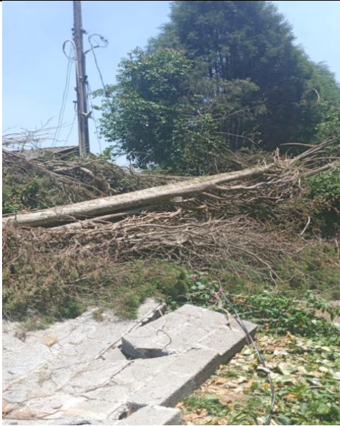
Figura 39 - Evidência de Campo - Sul, São Roque/SP – Fonte: CPFL Piratininga
