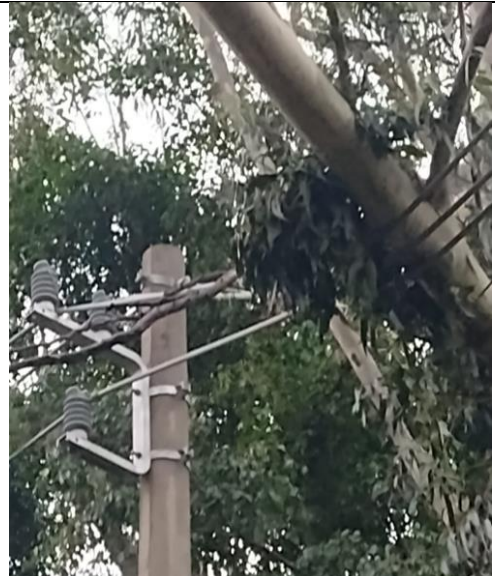
Figura 20 - Evidência de Campo - Sul, Boituva/SP – Fonte: CPFL Piratininga
