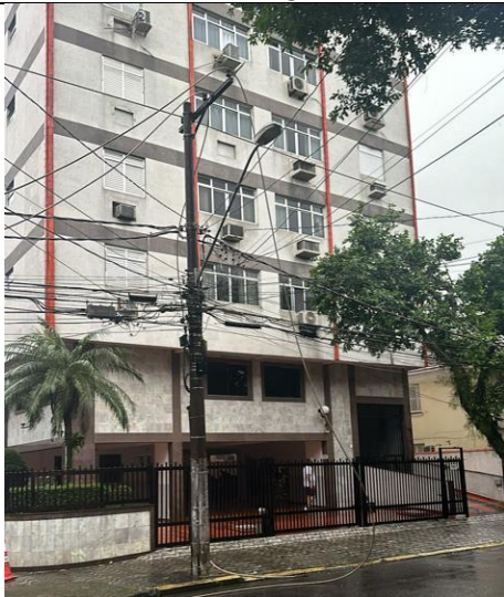
Figura 41 - Evidência de Campo – Baixada Santista, Santos/SP – Fonte: CPFL Piratininga
