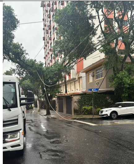
Figura 42 - Evidência de Campo - Baixada Santista, Santos /SP – Fonte: CPFL Piratininga
