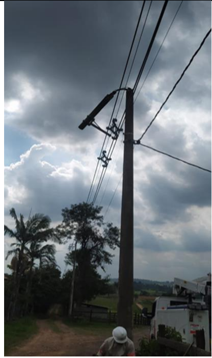
Figura 22 - Evidência de Campo - Sul, Boituva/SP – Fonte: CPFL Piratininga
