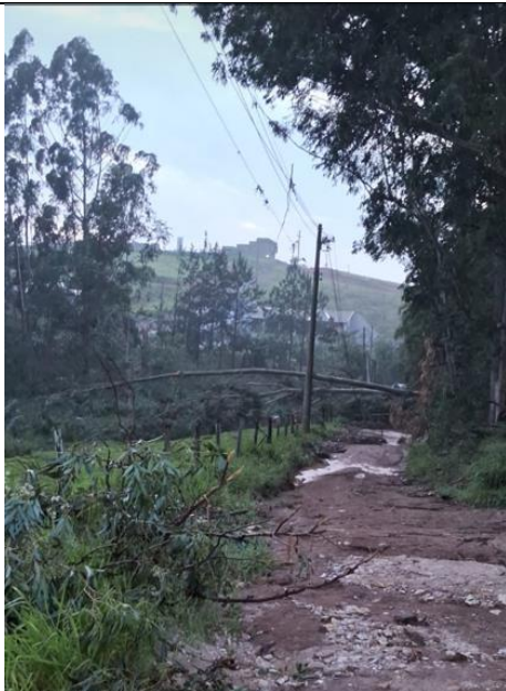
Figura 69 - Evidência de Campo - Leste, Águas de Lindóia/SP – Fonte: CPFL Paulista
