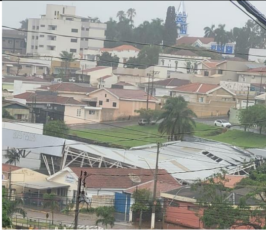
Figura 49 - Evidência de Campo - Nordeste, Altinópolis/SP – Fonte: CPFL Paulista
