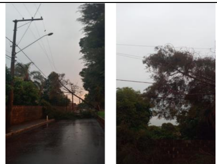
Figura 32 - Evidência de Campo – Centro, Rincão/SP – Fonte: CPFL Paulista
