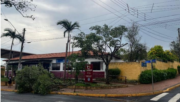
Figura 27 - Evidência de Campo - Centro, Brotas/SP – Fonte: CPFL Paulista
