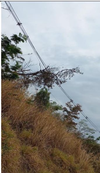
Figura 29 - Evidência de Campo – Centro, Matão/SP – Fonte: CPFL Paulista
