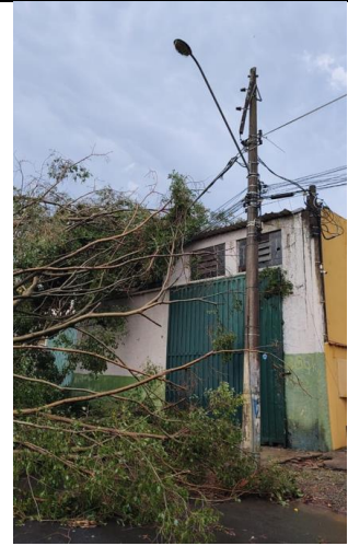
Figura 68 - Evidência de Campo - Leste, Espírito Santo do Pinhal/SP – Fonte: CPFL Paulista
