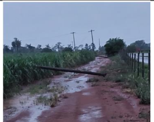
Figura 42 - Evidência de Campo – Noroeste, Penápolis/SP – Fonte: CPFL Paulista
