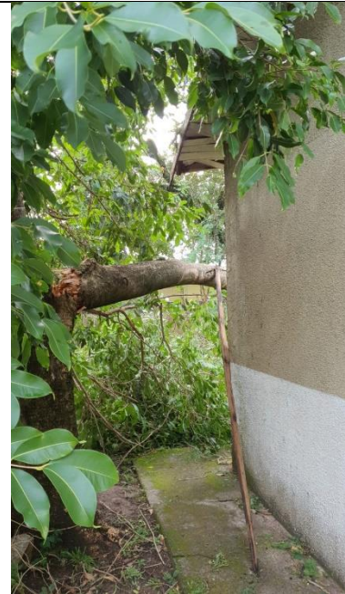
Figura 66 - Evidência de Campo – Centro Sul, Piracicaba/SP – Fonte: CPFL Paulista
