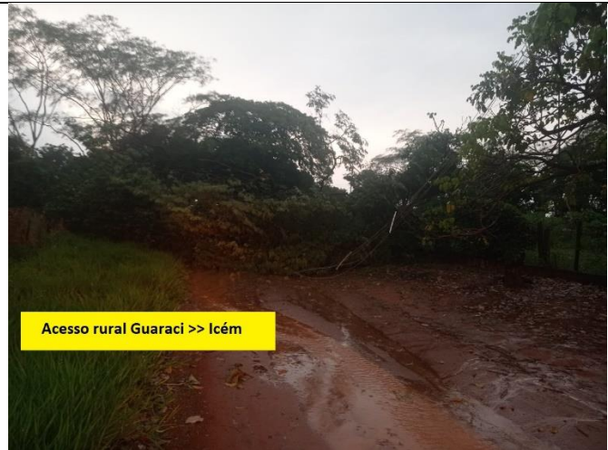
Figura 52 - Evidência de Campo - Norte, Guaraci/SP – Fonte: CPFL Paulista
