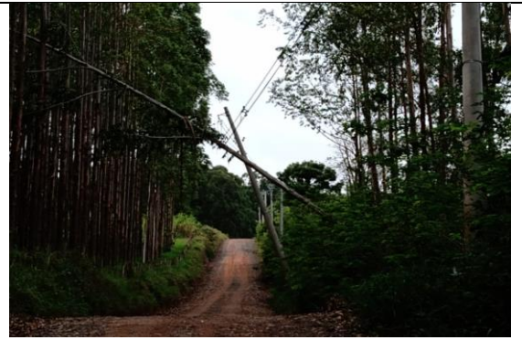
Figura 74 - Evidência de Campo - Leste, Campinas/SP – Fonte: CPFL Paulista
