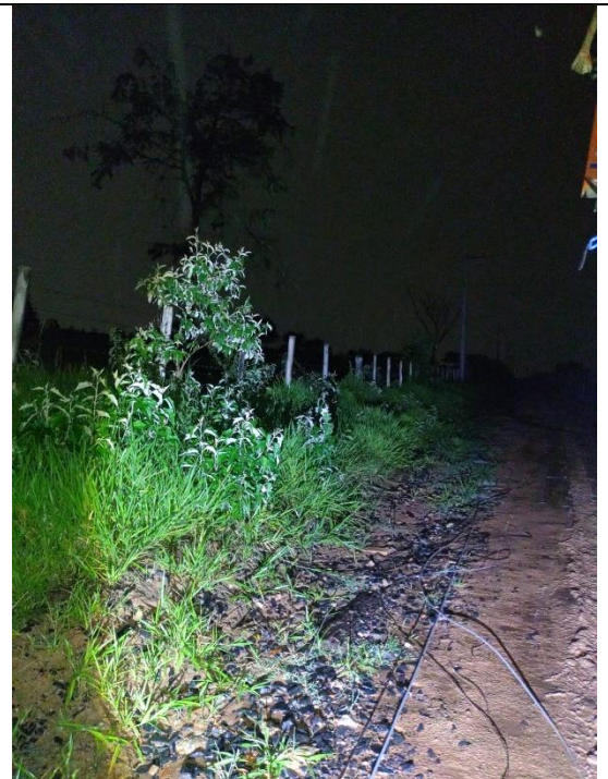
Figura 78 - Evidência de Campo - - Leste, Campinas/SP – Fonte: CPFL Paulista
