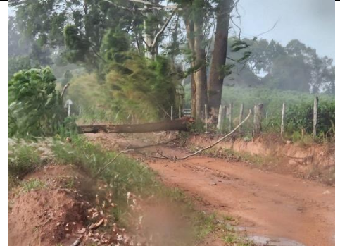
Figura 28 - Evidência de Campo - Centro, Brotas/SP – Fonte: CPFL Paulista
