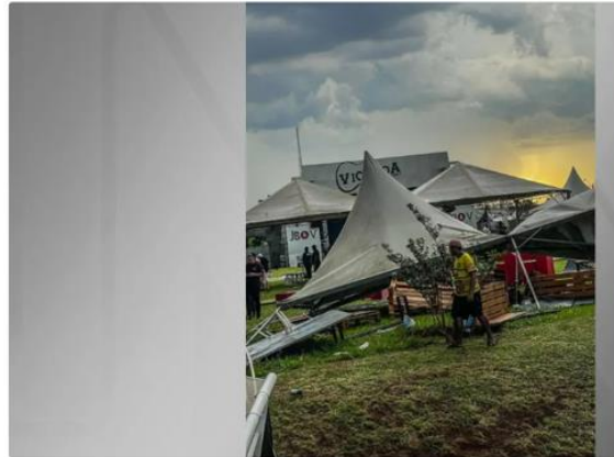
Tempestade destrói estrutura de show no interior de SP Reprodução
