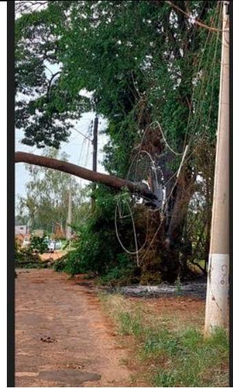
Figura 38 - Evidência de Campo – Noroeste, Araçatuba/SP – Fonte: CPFL Paulista
