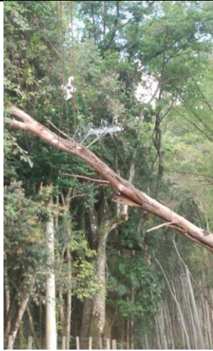
Figura 67 - Evidência de Campo - Leste, Espírito Santo do Pinhal/SP – Fonte: CPFL Paulista
