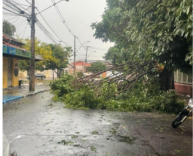
Figura 46 - Evidência de Campo - Nordeste, Franca/SP – Fonte: CPFL Paulista
