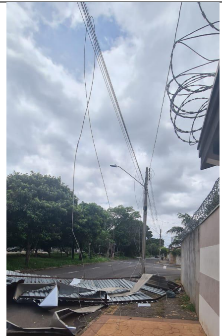
Figura 65 - Evidência de Campo – Centro Sul, Americana/SP – Fonte: CPFL Paulista
