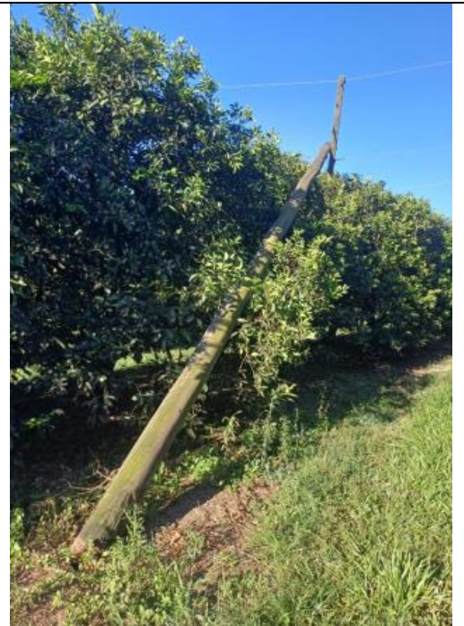
Figura 87 - Evidência de Campo - Oeste, Bofete/SP – Fonte: CPFL Paulista
