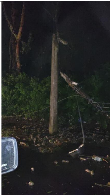
Figura 42 - Evidência de Campo - Nordeste, Altinópolis/SP – Fonte: CPFL Paulista
