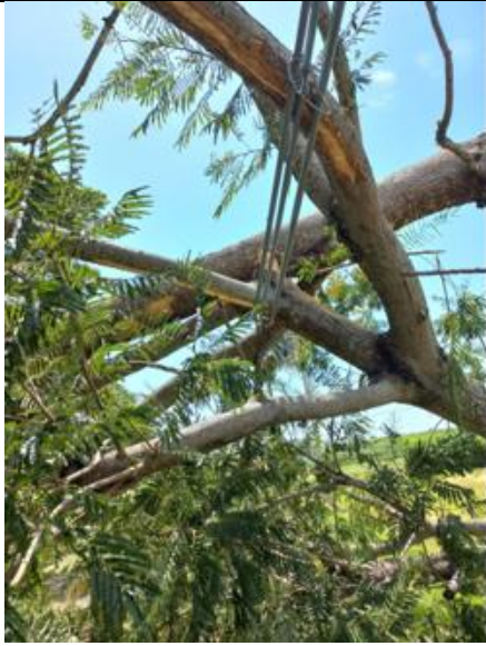
Figura 34 - Evidência de Campo – Noroeste, Penápolis/SP – Fonte: CPFL Paulista
