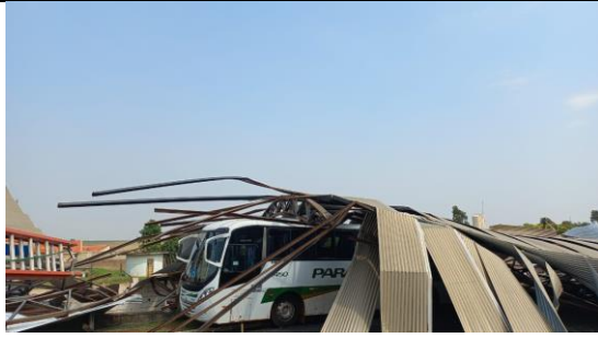
Figura 26 - Evidência de Campo – Centro, Matão/SP – Fonte: CPFL Paulista
