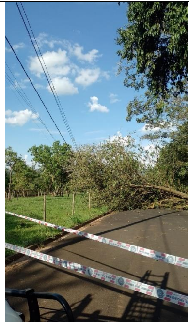
Figura 43 - Evidência de Campo - Nordeste, Franca/SP – Fonte: CPFL Paulista
