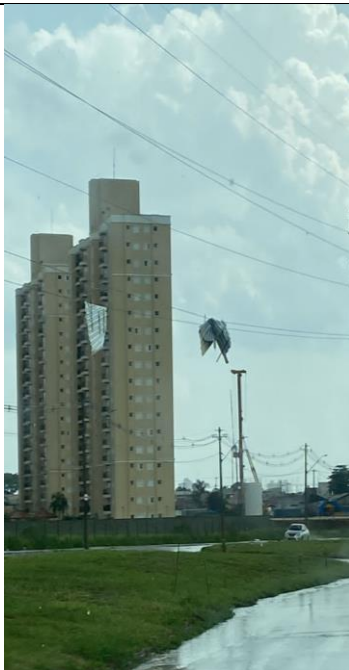
Figura 64 - Evidência de Campo – Centro Sul, Americana/SP – Fonte: CPFL Paulista
