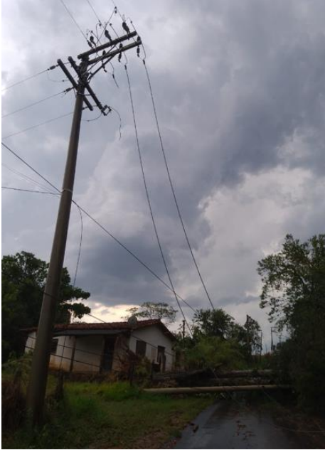
Figura 72 - Evidência de Campo - Leste, Espírito Santo do Pinhal/SP – Fonte: CPFL Paulista
