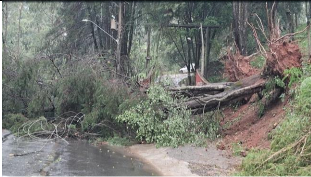
Figura 74 - Evidência de Campo - Leste, Águas de Lindóia/SP – Fonte: CPFL Paulista
