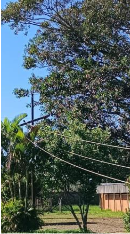
Figura 88 - Evidência de Campo - Oeste, Botucatu/SP – Fonte: CPFL Paulista
