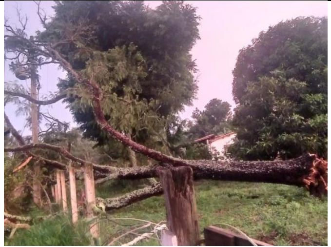
Figura 85 - Evidência de Campo - Oeste, Bofete/SP – Fonte: CPFL Paulista
