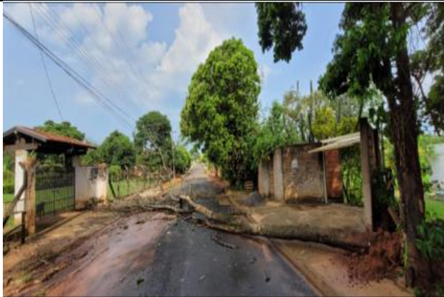
Figura 36 - Evidência de Campo – Noroeste, Lins/SP – Fonte: CPFL Paulista
