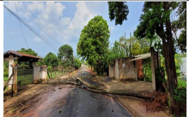
Figura 31 - Evidência de Campo – Noroeste, Araçatuba/SP – Fonte: CPFL Paulista
