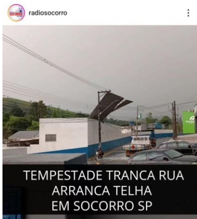
Figura 82 - Evidência de Campo - Leste, Socorro/SP – Fonte: Internet
