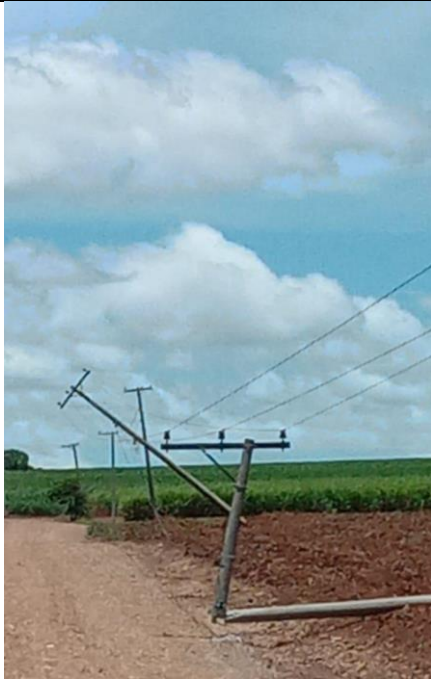
Figura 66 - Evidência de Campo – Centro Sul, Americana/SP – Fonte: CPFL Paulista
