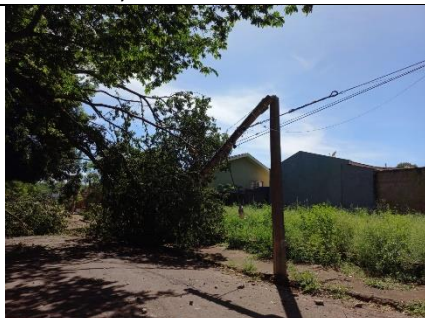
Figura 58 - Evidência de Campo - Ourinhos, Ourinhos/SP – Fonte: CPFL Santa Cruz
