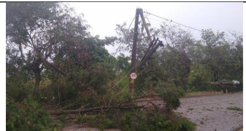
Figura 23 - Evidência de Campo – Itapetininga, Itapetininga/SP – Fonte: CPFL Santa Cruz
