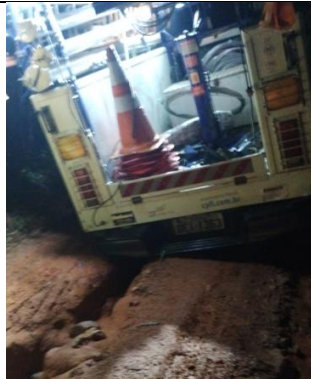
Figura 36 - Evidência de Campo – SJ Rio Pardo, São José do Rio Pardo/SP – Fonte: CPFL Santa Cruz
