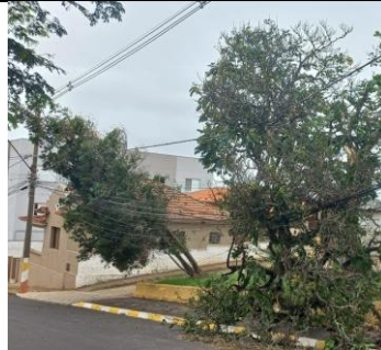
Figura 32 - Evidência de Campo – Avaré, Avaré/SP – Fonte: CPFL Santa Cruz
