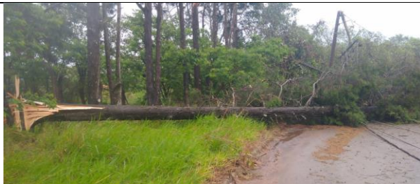
Figura 22 - Evidência de Campo – Itapetininga, Itapetininga/SP – Fonte: CPFL Santa Cruz
