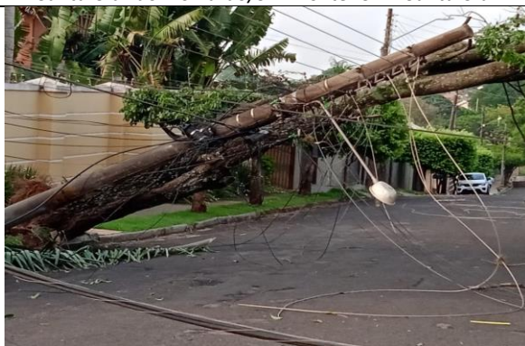
Figura 56 - Evidência de Campo - Ourinhos, Ourinhos/SP – Fonte: CPFL Santa Cruz
