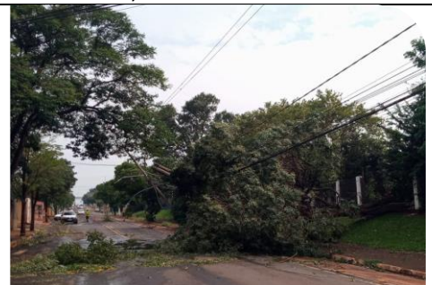
Figura 59 - Evidência de Campo - Ourinhos, Ourinhos/SP – Fonte: CPFL Santa Cruz
