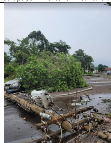
Figura 29 - Evidência de Campo – Avaré, Avaré/SP – Fonte: CPFL Santa Cruz
