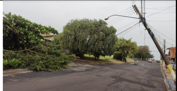
Figura 33 - Evidência de Campo – Avaré, Avaré/SP – Fonte: CPFL Santa Cruz
