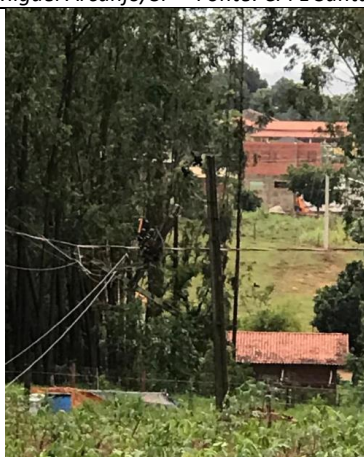
Figura 28 - Evidência de Campo – Itapetininga, Sarapuí/SP – Fonte: CPFL Santa Cruz
