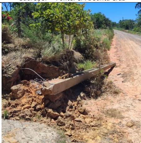
Figura 26 - Evidência de Campo – Itapetininga, São Miguel Arcanjo/SP – Fonte: CPFL Santa Cruz
