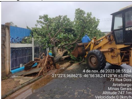
Figura 46 - Evidência de Campo - Mococa, Arceburgo/SP – Fonte: CPFL Santa Cruz
