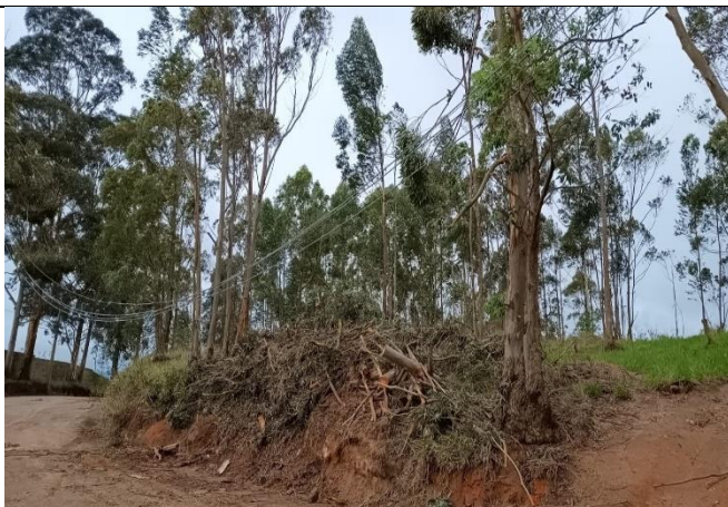
Figura 35 - Evidência de Campo - Leste, Valinhos/SP – Fonte: CPFL Paulista
