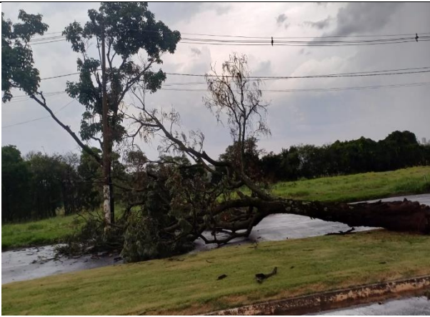
Figura 21 - Evidência de Campo - Centro, Descalvado/SP – Fonte: CPFL Paulista
