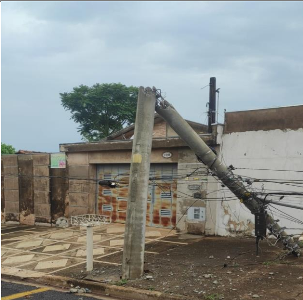
Figura 39 - Evidência de Campo - Nordeste, Franca/SP – Fonte: CPFL Paulista
