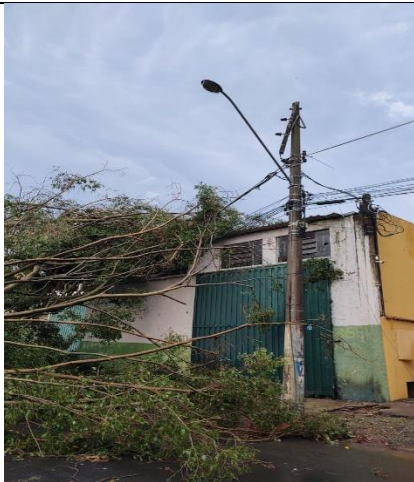
Figura 33 - Evidência de Campo - Leste, Itapira/SP – Fonte: CPFL Paulista
