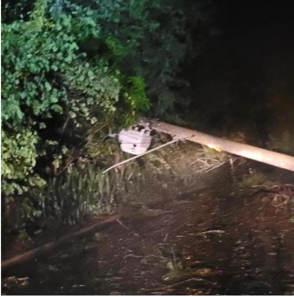
Figura 23 - Evidência de Campo - Centro, Araraquara/SP – Fonte: CPFL Paulista
