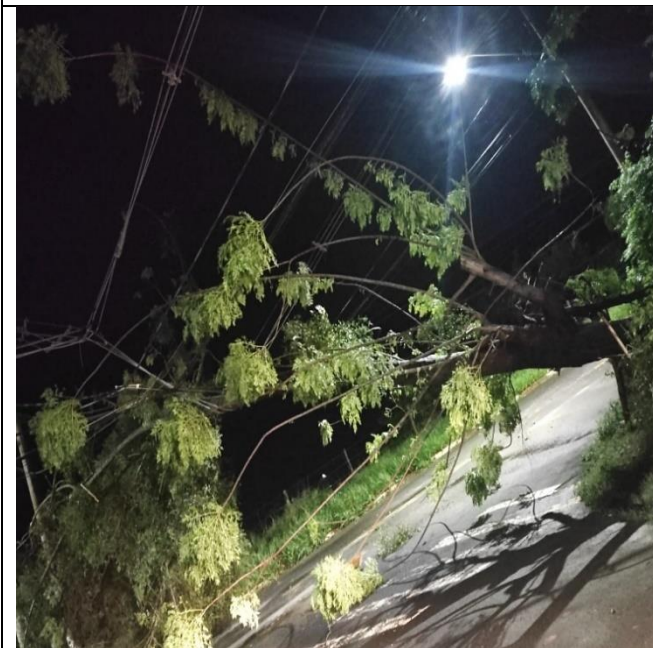
Figura 48 - Evidência de Campo - Leste, Itapira/SP – Fonte: CPFL Paulista
