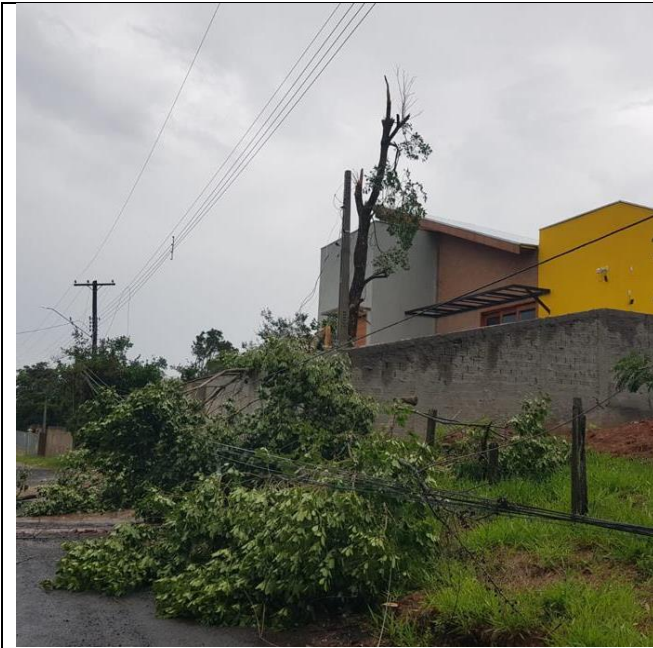
Figura 54 - Evidência de Campo - Oeste, Botucatu/SP – Fonte: CPFL Paulista
