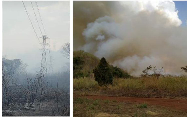
Figura 35 - Registro Fotográfico – Desligamento da LT ARA – FSA
