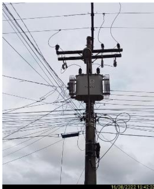
Figura 24 - Evidência de Campo. Fonte: RGE
