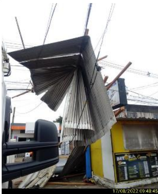
Figura 15 - Evidência de Campo. Fonte: RGE
