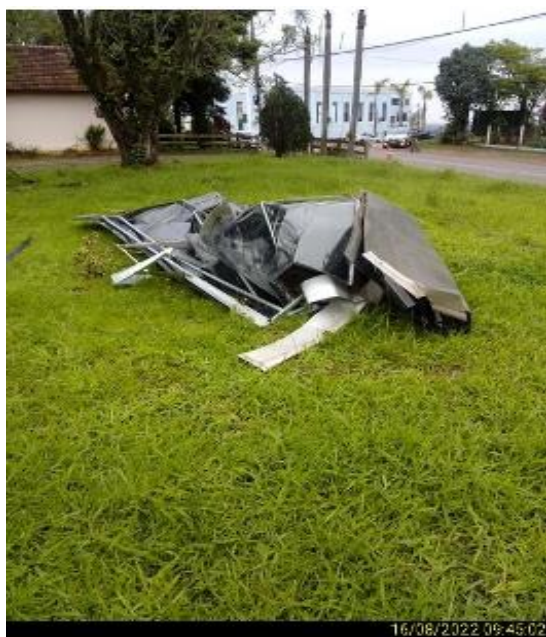
Figura 31 - Evidência de Campo. Fonte: RGE
