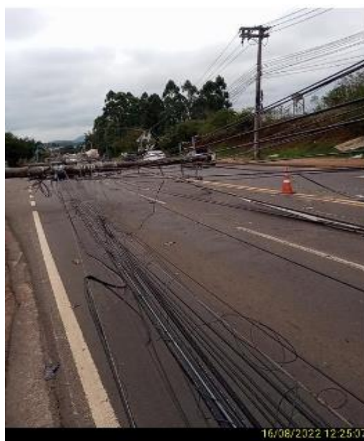
Figura 18 - Evidência de Campo. Fonte: RGE
