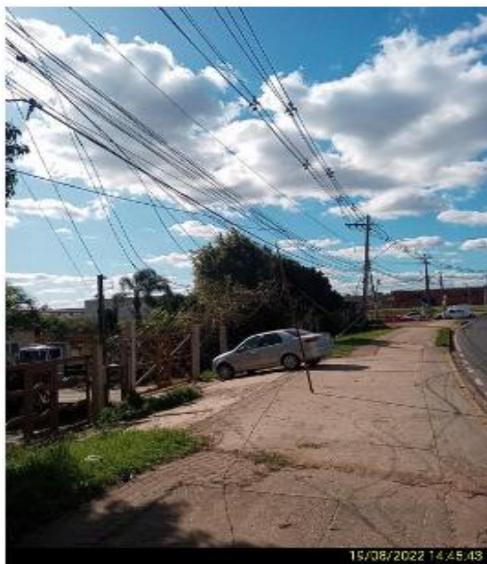
Figura 23 - Evidência de Campo. Fonte: RGE
