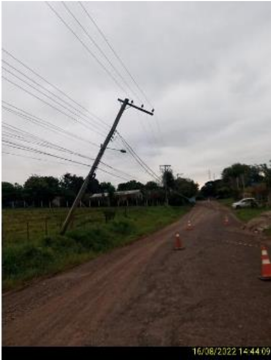
Figura 27 - Evidência de Campo. Fonte: RGE
