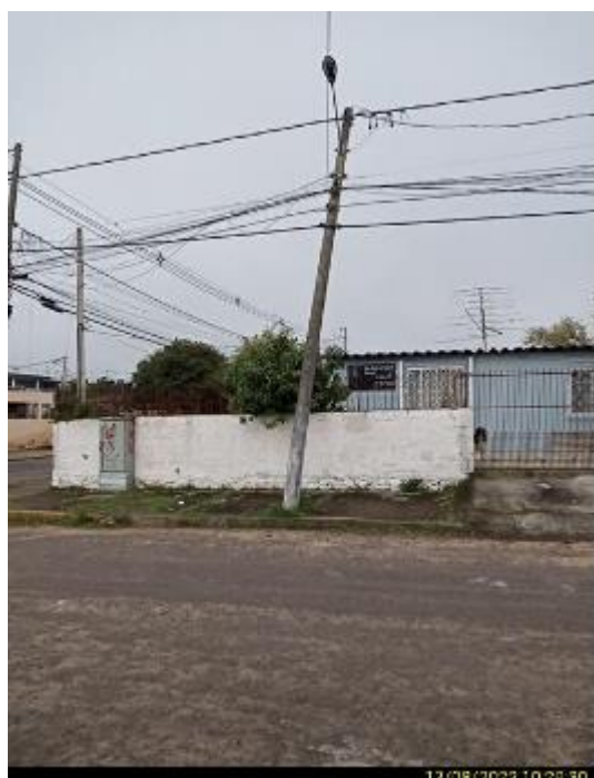
Figura 21 - Evidência de Campo. Fonte: RGE
