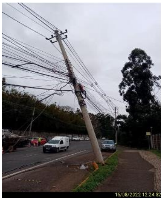
Figura 17 - Evidência de Campo. Fonte: RGE
