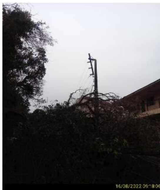
Figura 26 - Evidência de Campo. Fonte: RGE
