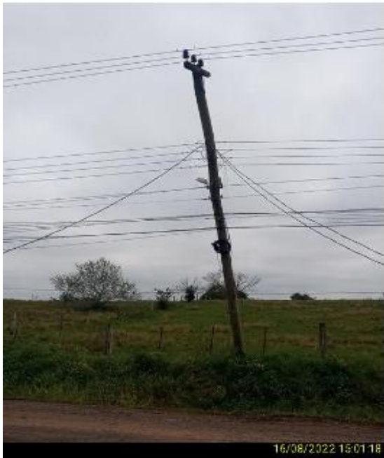
Figura 29 - Evidência de Campo. Fonte: RGE
