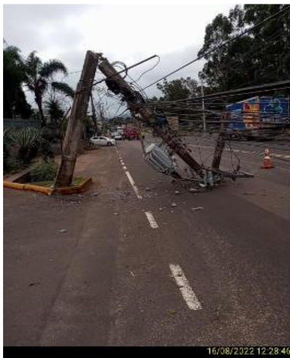
Figura 19 - Evidência de Campo. Fonte: RGE
