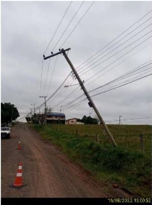
Figura 28 - Evidência de Campo. Fonte: RGE
