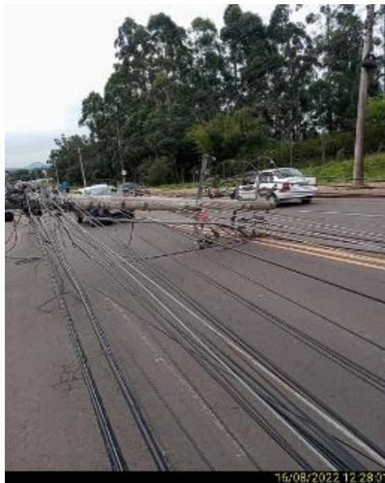
Figura 20 - Evidência de Campo. Fonte: RGE
