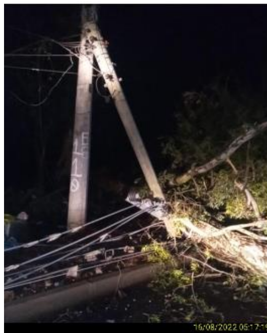
Figura 32 - Evidência de Campo. Fonte: RGE
