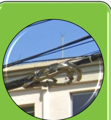
Não é permitido a fixação de suporte (ou dispositivo) de reserva técnica do tipo cruz (optiloop cruzeta) nos postes ou no meio do vão, apenas no modo espinado conforme ABNT NBR 15214/2005.
