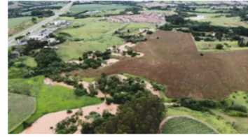
Região do bairro São José, em Capivari, tem áreas alagadas após rio transbordar — Foto: Prefeitura de Capivari
