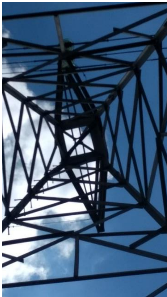
Foto 14 - Vista interna torção na estrutura 81
