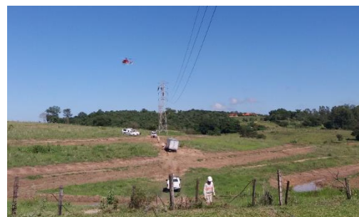
Foto 22 - Lançamento dos cabos C2
