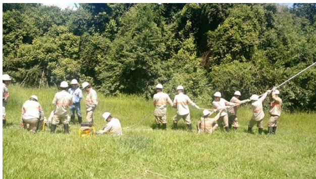
Foto 17 - Levantamento dos cabos do circuito 1
