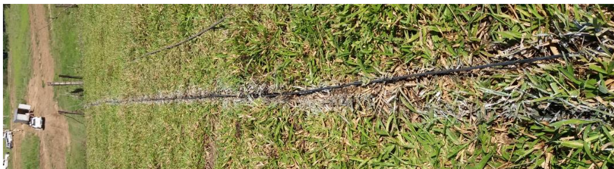
Foto 5 - Cabo guarda do circuito 2 com sinais de descargas
