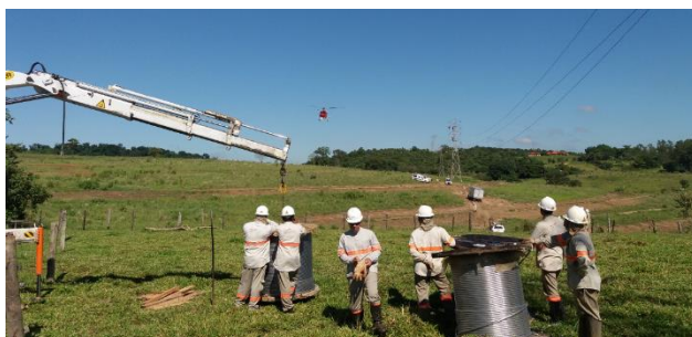
Foto 21 - Lançamento dos cabos C2
