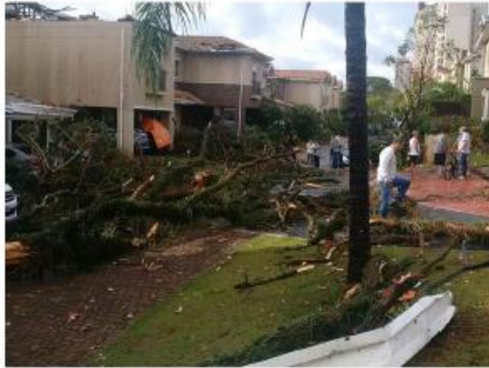
Casas foram destruídas em condomínio no Taquaral (Foto: Divulgação/Arquivo Pessoal)
