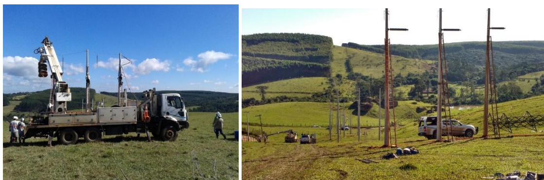
Figura 34 - Equipes reconstruindo LT 88kV Oeste - São Roque 01
