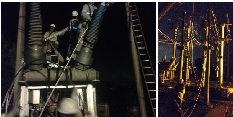
Figura 33 - Equipes realizando reconstrução de trecho SE Itu 2 - Rondon
