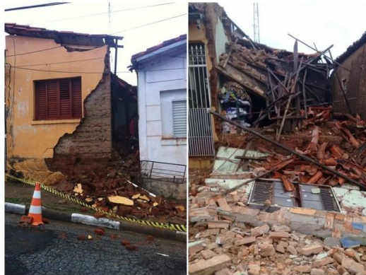
Casa desabou após chuva forte em Porto Feliz. (Foto: Moisés Soares/ TV TEM)
